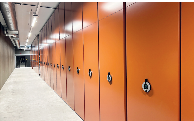
I byggets kjelleretasje finner vi blant annet 14.000 hyllemeter med arkivreoler for Statsarkivet.
